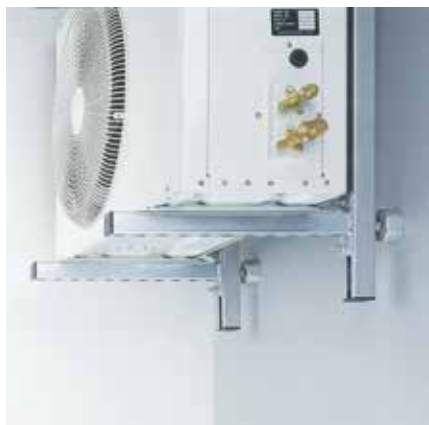
Schallentkoppelte Wandbefestigung
