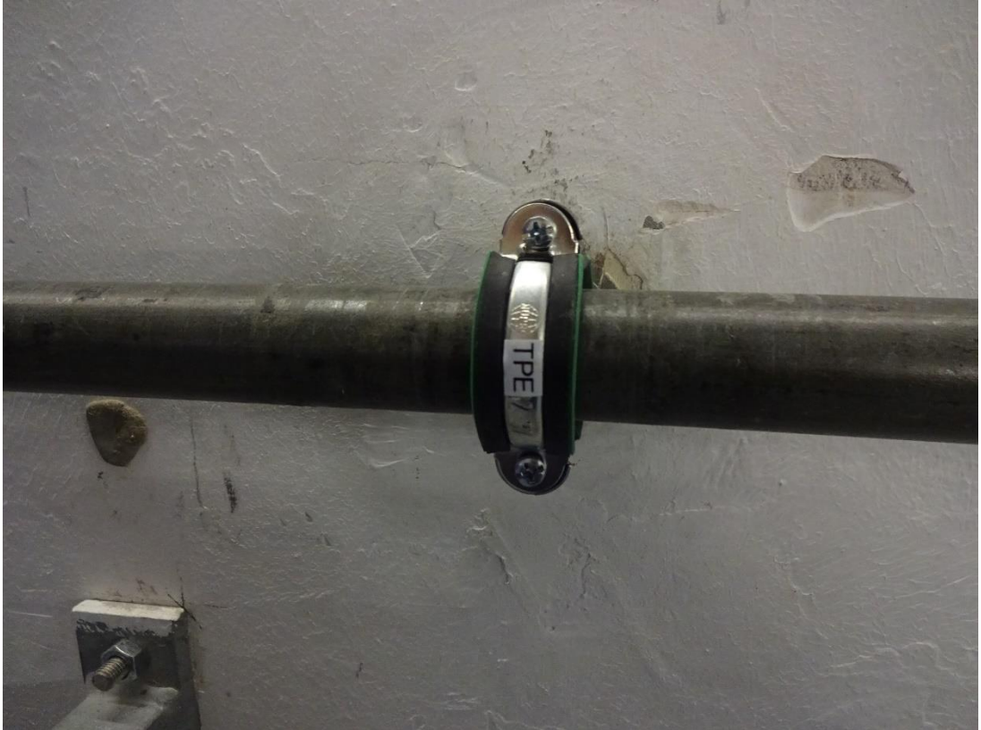
Bild 3: Rohrschelle MÜPRO Optimal, 1" (32 - 37 mm), M8, verzinkt mit Einlage DÄMMGULAST® GRÜN
