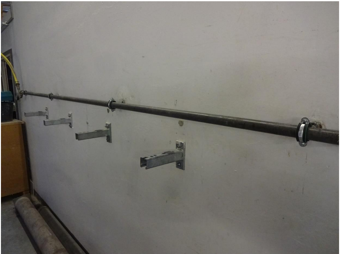
Bild 4: Rohrschelle MÜPRO Optimal, 1" (32 - 37 mm), M8, verzinkt mit Einlage DÄMMGULAST® GRÜN
