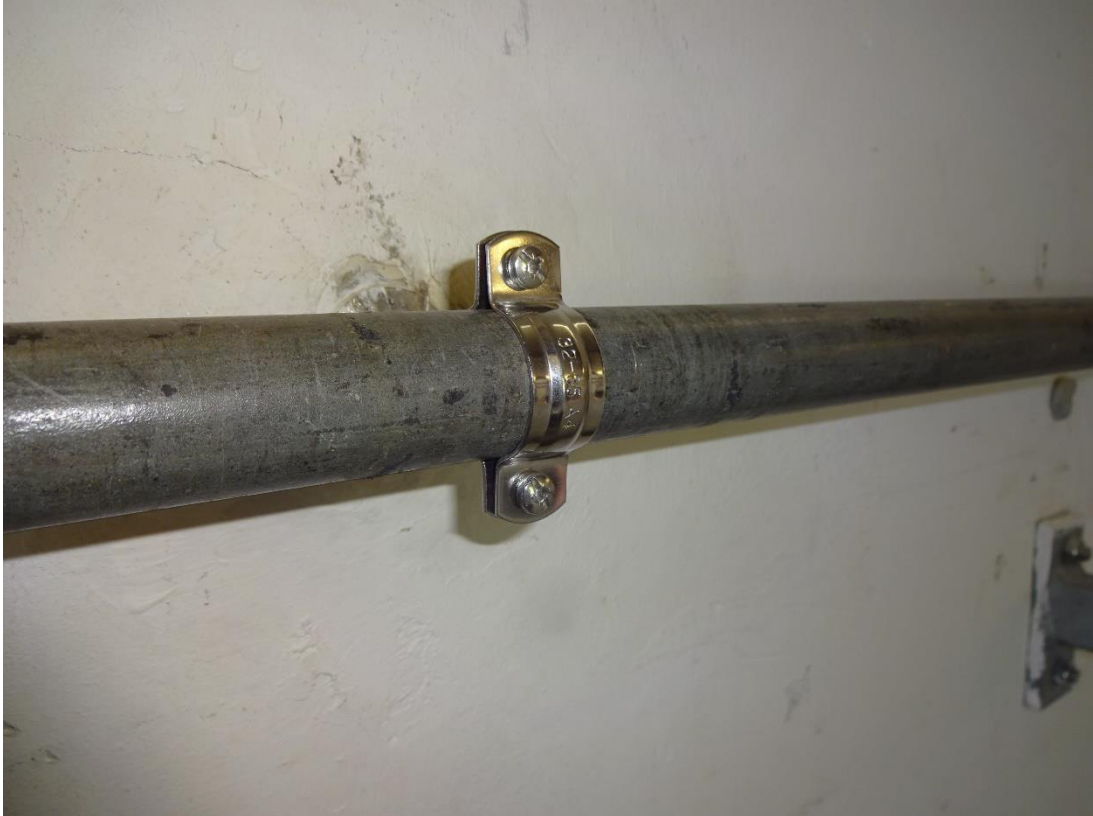
Bild 1: Bezugsmessung: V2A Schelle ohne Dämmeinlage, 1" (32 - 35 mm), Anschluss M8/10, starrer Anschluss
