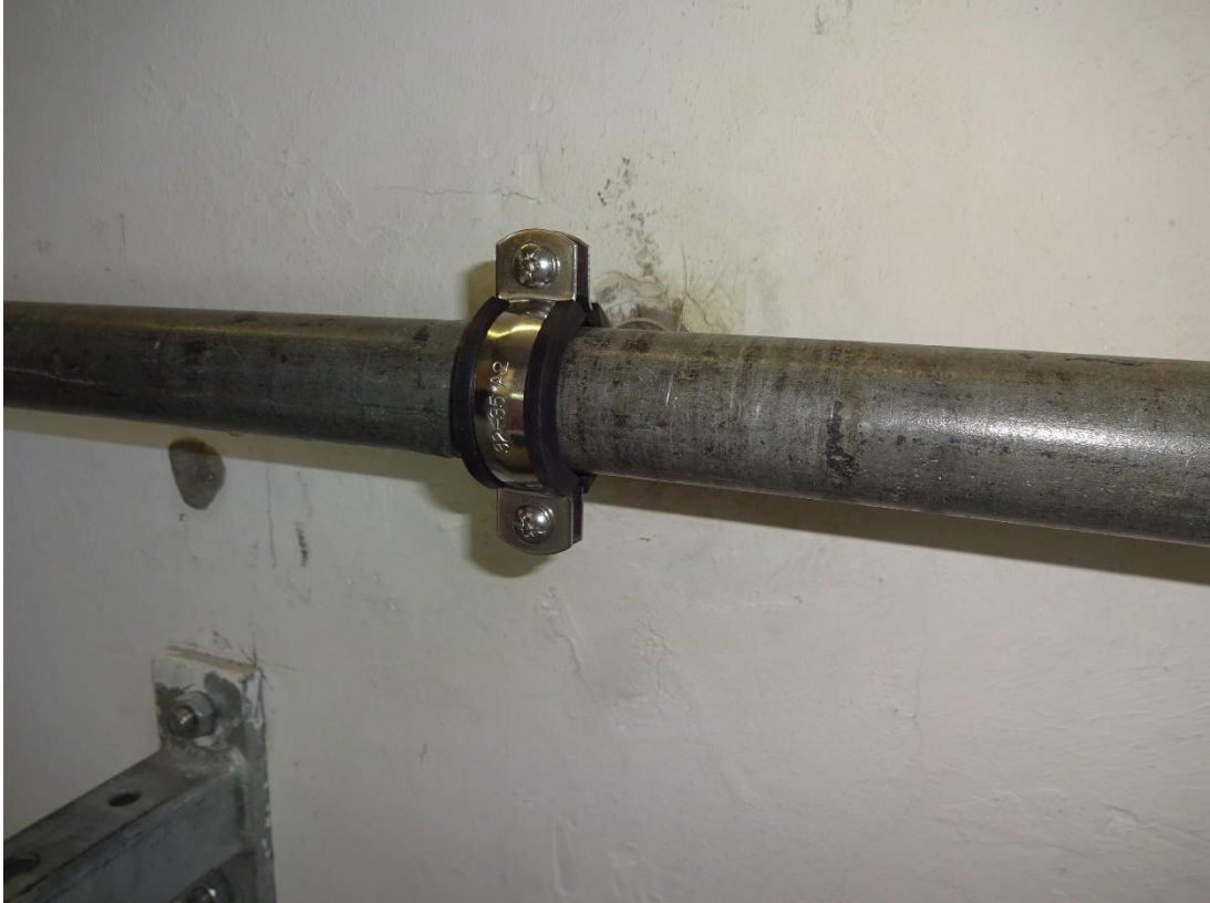
Bild 3: Messung 1: V2A Schraubrohrschele DÄMMGULAST®, schwarz, 1" (32 - 35 mm), Anschluss M8/10
